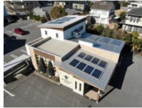
オーシャンキッズクリニックに設置したペラペラ太陽光 (出所：ティーエスピー) クリックすると拡大した画像が開きます
